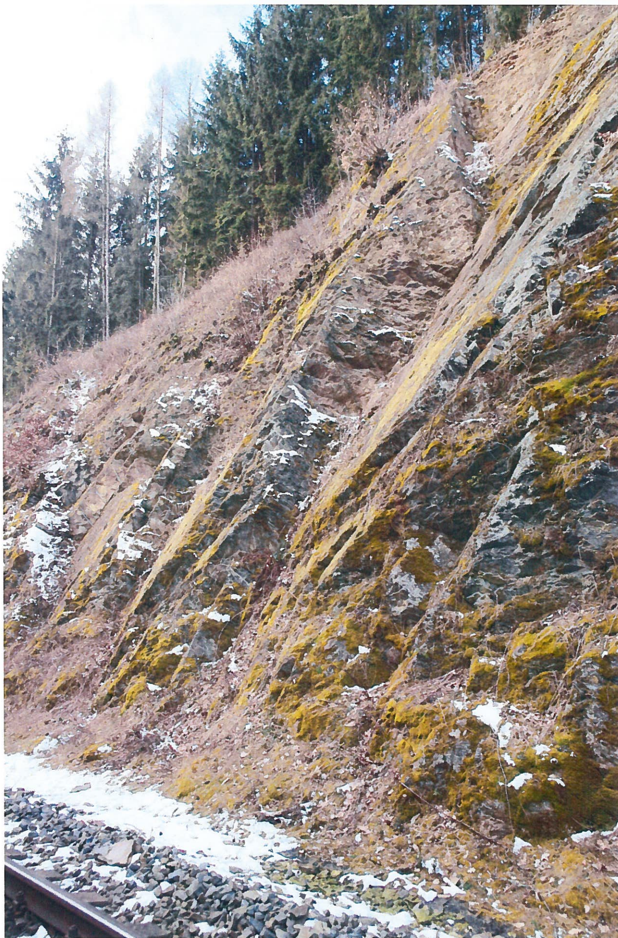
Foto – 13 Pohled k Uničovu vlevo na puklinové systémy v km 26,400 – 26,420.
