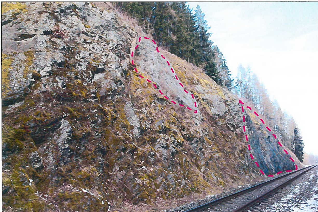
Foto – 9 Pohled vlevo na část nezasít'ovaného svahu a část již zasít'ovaného od v km 26,420. Karmínová čára omezuje položené sítě v minulosti na části levého svahu.
