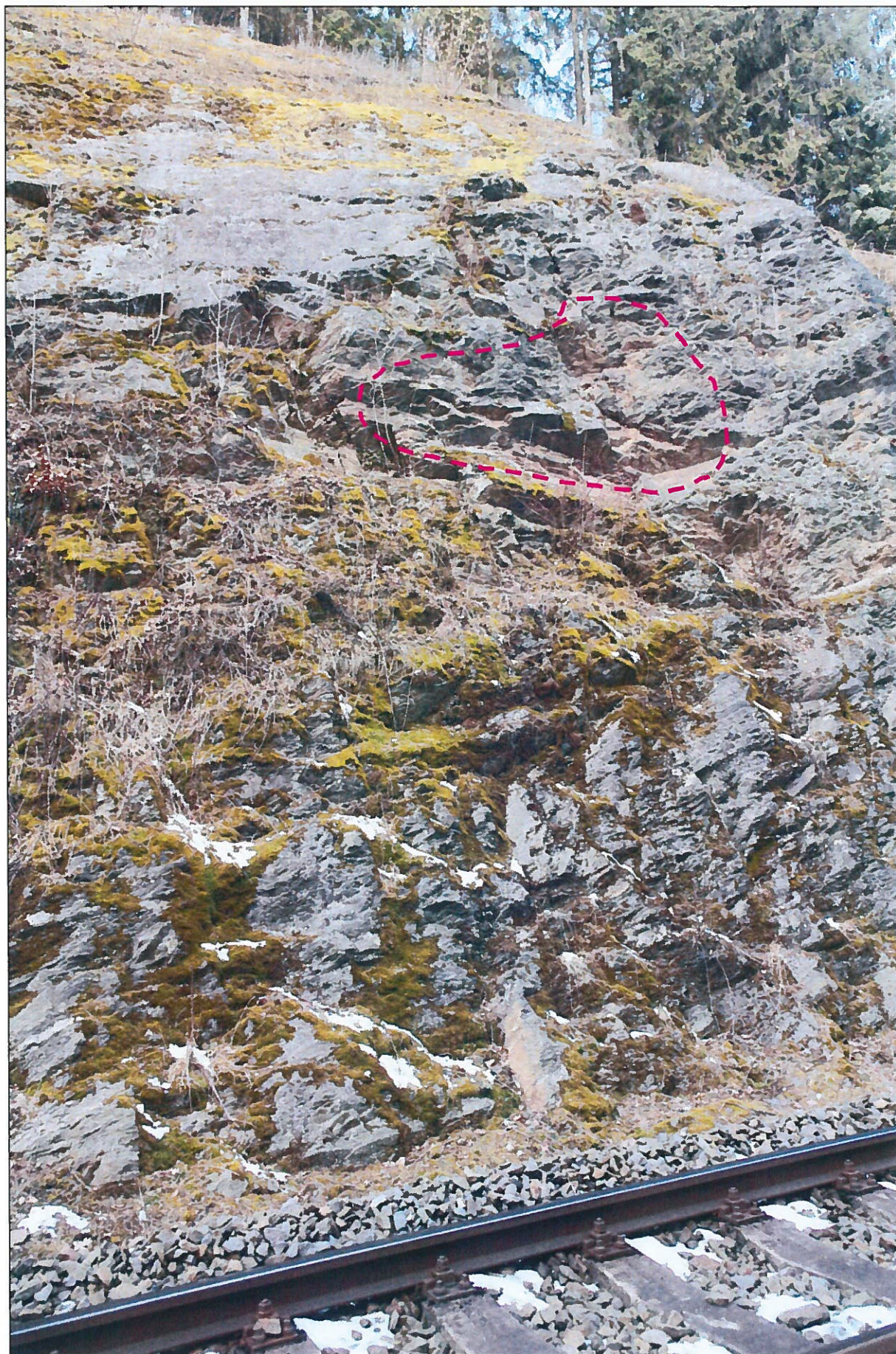
Foto – 16 Pohled vlevo v km 26,480 na nedávné vypadnutí fragmentů z líce svahu.
