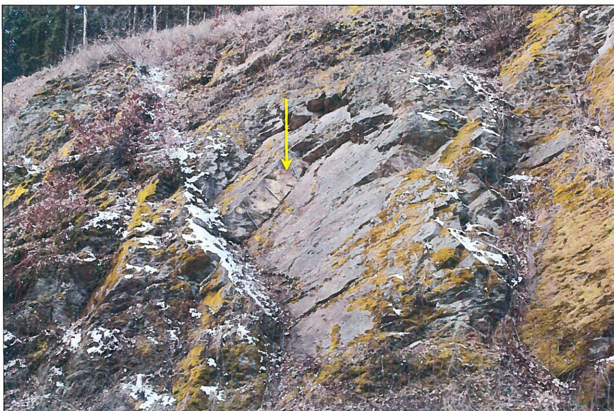
Foto – 10 Pohled na svah vlevo s tyčovou fortifikací pod skalním blokem viz šipka.
