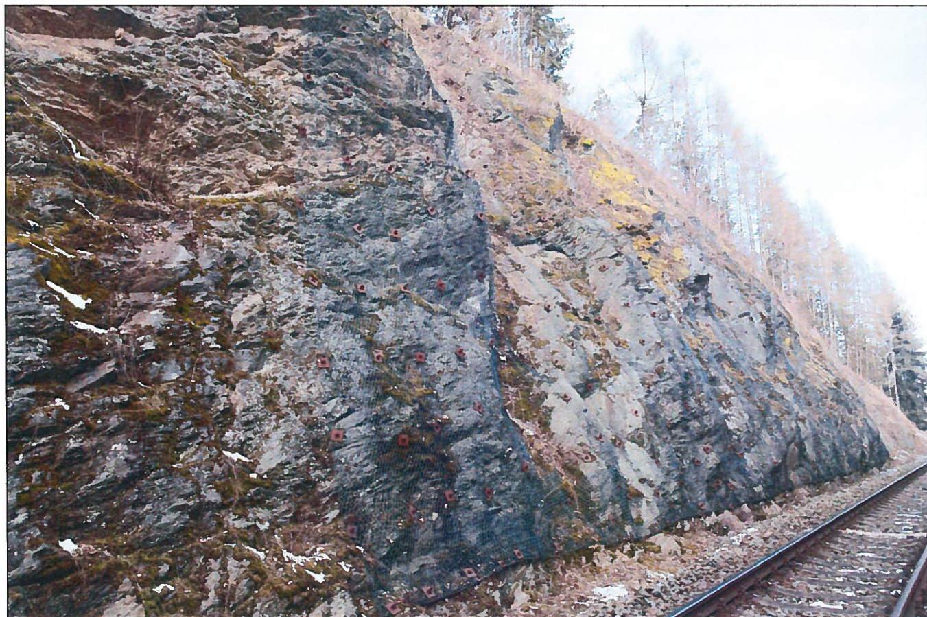
Foto – 15 Pohled k Šumperku na zasítovaný svah s tyčovými kotevními prvky v km 26,480 – 26,530.
