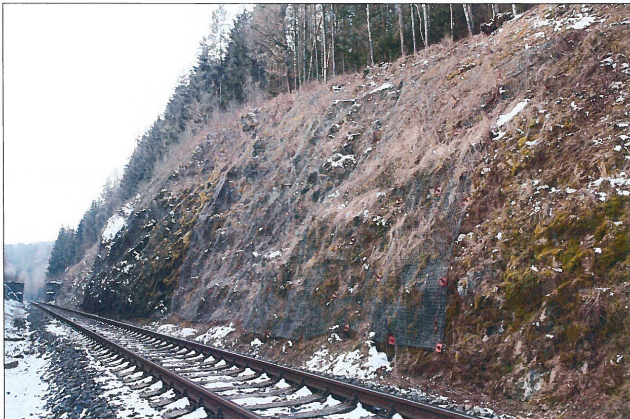
Foto – 17 Pohled k Uničovu vlevo. Posledních cca 20 sítí nedosahuje k horní hraně.
