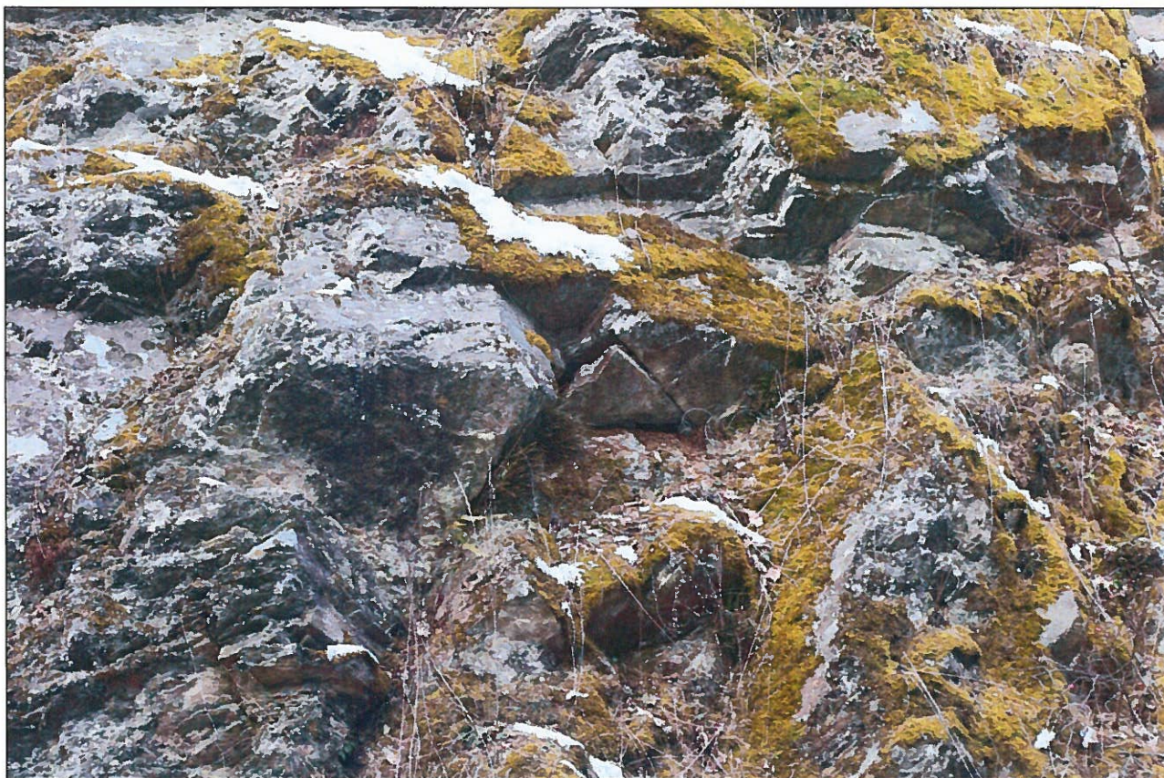
Foto – 12 Pohled vlevo v km 26,440 na uvolněné fragmenty v líci cca 2,0 m na patou svahu.
