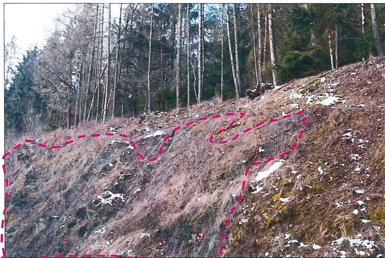
Foto – 18 Detailní pohled vlevo na horní partii svahu s absencí sítí na hraně svahu viz foto 17. Karmínová čára omezuje rozsah sítí na svahu.
